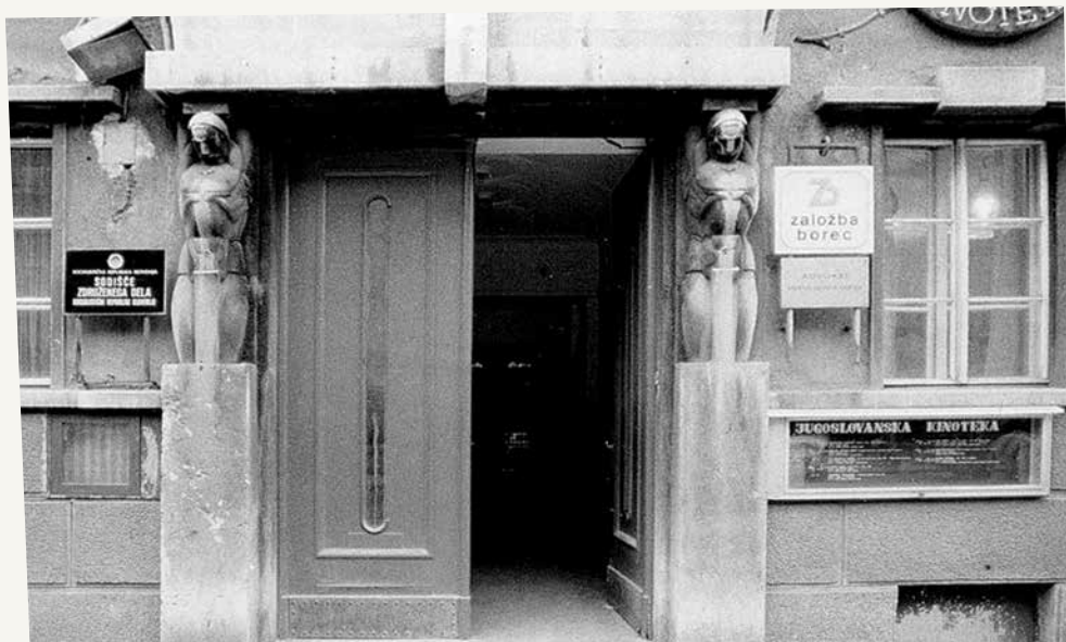
Portal palače Delavske zbornice na Miklošičevi cesti 28 arhitekta Vladimirja Šubica (zgrajena 1928, z atlantoma Lojzeta Dolinarja)
